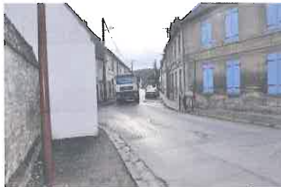
RD 44 -Circulation, stationnement voie étroite, trottoirs exigus.
